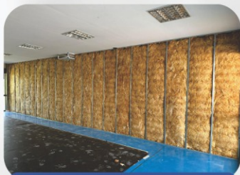
Isolamento termo-acústico
